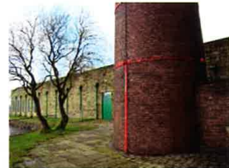
004 - Queens Mill Millpond
